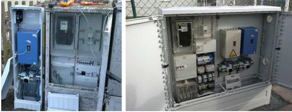
Blauer Schaltkasten= dimmlight
