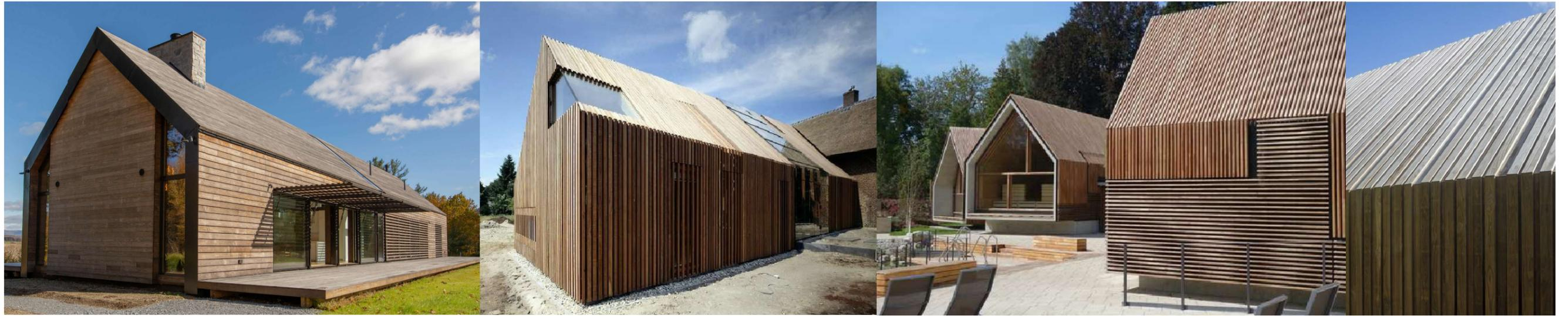
Bauen in naturnaher Umgebung und in Wassernähe mit einer Gebäudehülle aus nachwachsenden Rohstoffen in Holzbauweise, Fassadenbekleidungen in Lärchenholz unbehandelt oder mit Vergrauungslasur in Anlehnung an ein Strandhaus, Dach-Oberdeckung Lärchenschalung analog Fassade oder Faserzement-Deckung, PV-Anlage und Solarpaneele integriert. Holzbauweise mit effizienter Möglichkeiten der Vorfertigung, kurze Bauzeit, geringere Trocknungszeiten.
