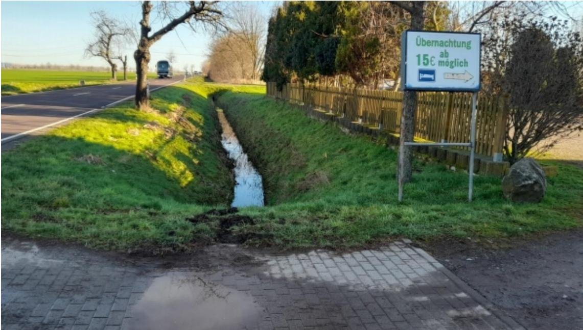
Mit der Verrohrung und der anschließenden Verfüllung des Grabens kann unter Beachtung der entsprechenden Regelwerke (Ausbaubreite, Trennstreifenbreite zur Fahrbahn und dgl.) im Straßenbau der Weg hergestellt werden. Voraussetzung ist in diesem Zusammenhang unter anderem, die Einhaltung wasserrechtlichen Bestimmungen (Untere Wasserbehörde, Naturschutzbehörde des Landkreises sowie Unterhaltungsverband Untere Ohre).
