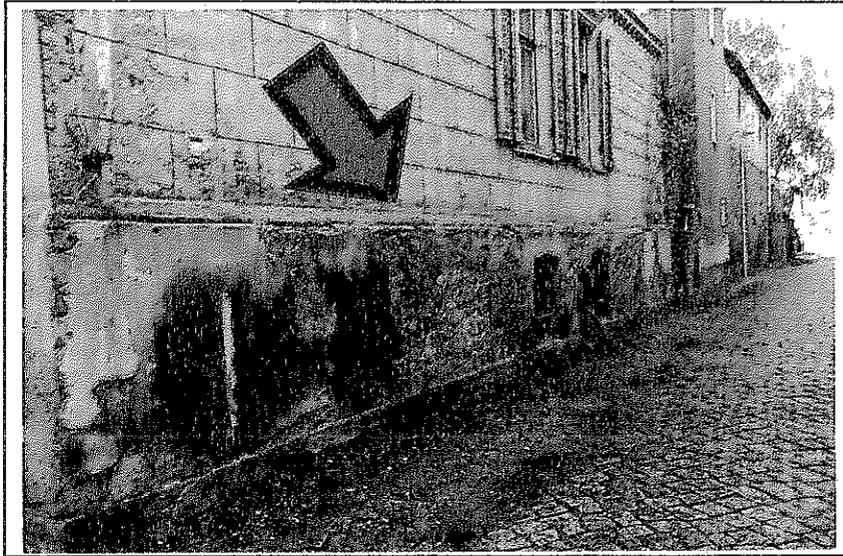
Bild 7 ... Feuchteschäden
