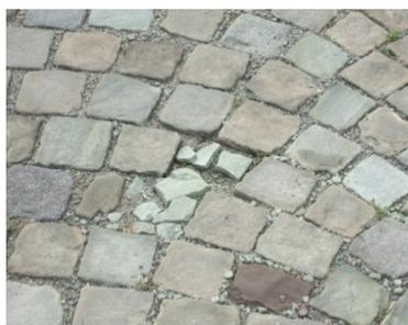
Einzelne Steinexemplare wurden regelrecht „zersprengt“. Je nachdem ob das Steinlager senkrecht oder Waagerecht eingepflastert wurde, zerteilt sich der Stein in 2 Hälften oder die obere Schicht löst sich und es entsteht ein Loch im Belag.
