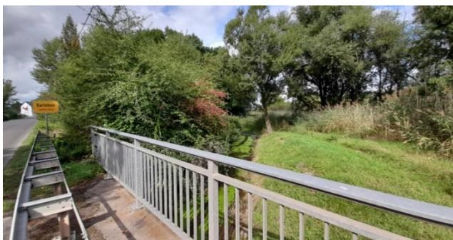
Aufgrund dessen, dass sich mit dem Versetzen der Ortstafel die Brücke innerorts befindet sind die Leitblanken (im Bereich der Geh-/ Radwegeführung) zurückzubauen.
