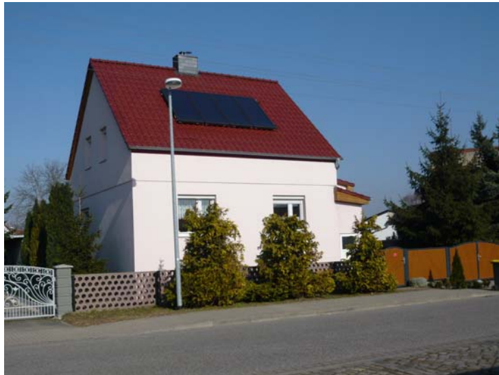
Gelungene Integration von Solarenergieanlagen
